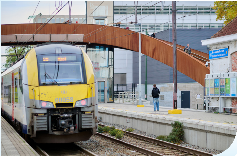
Exemples de gares entièrement remises en état à Genval et Berchem Ste-Agathe
