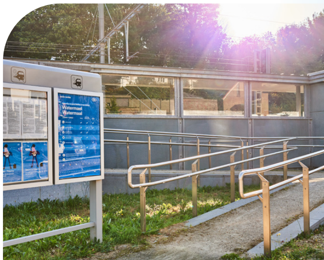
Exemple de rampe d'accès en gare de Watermael
