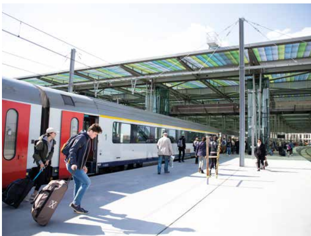
Les travaux en gare d'Ostende s'achèveront fin 2018. La marquise, le hall et le parking sont déjà terminés.
