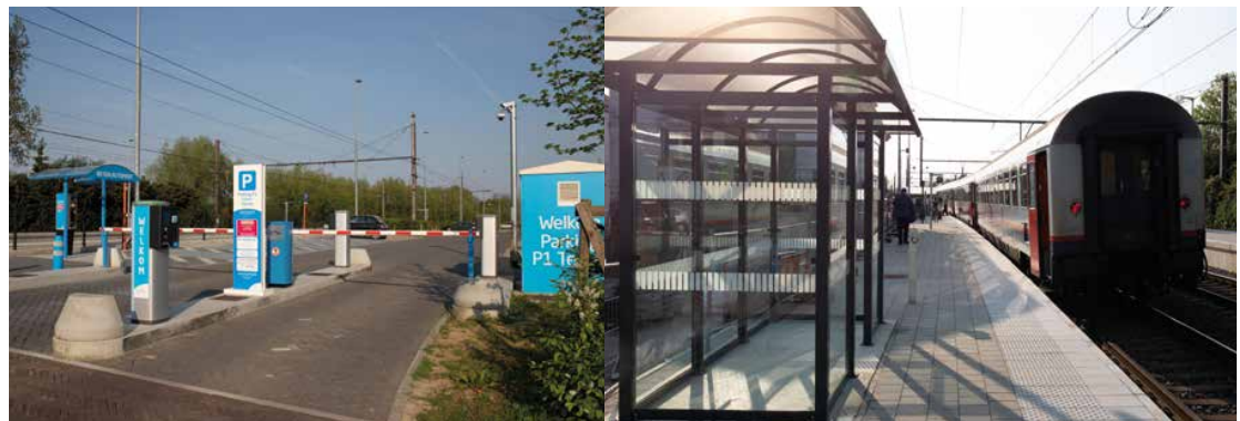
Grand parking fermé et quais rehaussés à Ternat.
