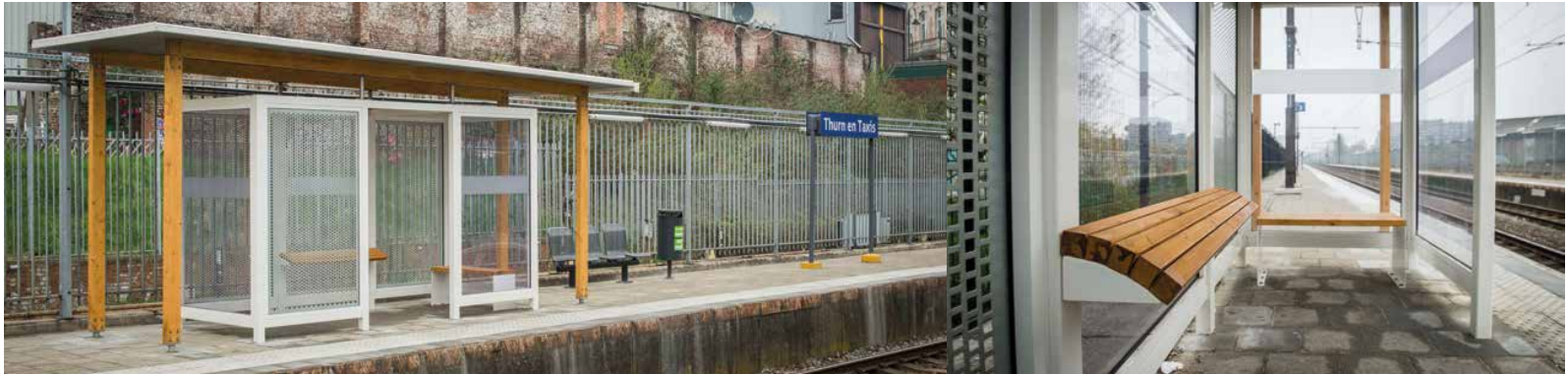
Les nouveaux abris de quai de la gare de Tour & Taxis à Bruxelles ont déjà été conçus conformément aux principes de la gare standard : spacieux et clairs, avec plus de sièges et de supports.
