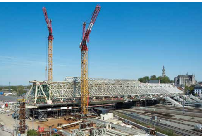
La nouvelle gare de Mons prend forme.
