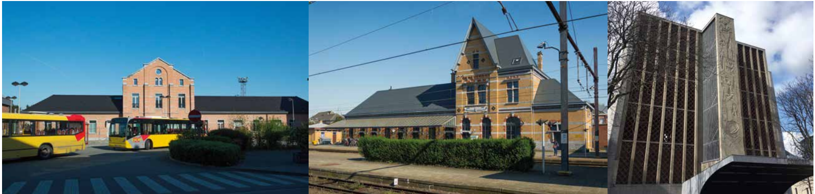
Les bâtiments de gare historiques de Jurbise et Lessines restaurés.
