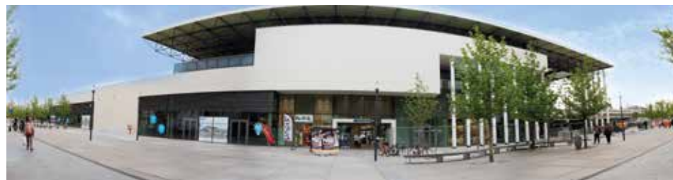
Het station van Roeselare is vernieuwd en deels herbouwd, terwijl ook de stationsomgeving wordt heraangelegd.
