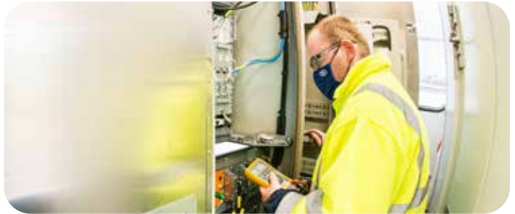
Subvention européenne pour l'installation de systèmes de sécurité ETCS
