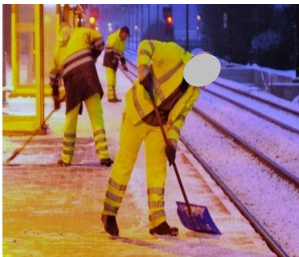
Figure 57 : Exemple d'empiètement de type I
