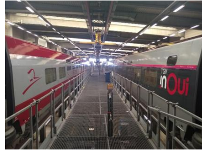
Figure 78 : Plancher de circulation
