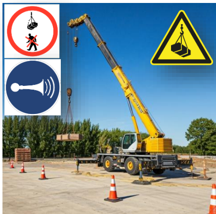
Figure 10 : Mesures de prévention liées à l'usage d'engins de levage
