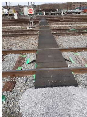
Figure 79 : Traversée de service
