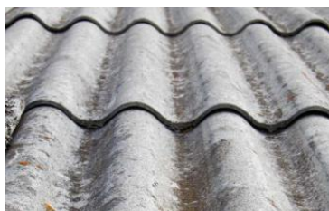
Figure 19 : Amiante-ciment en toiture
